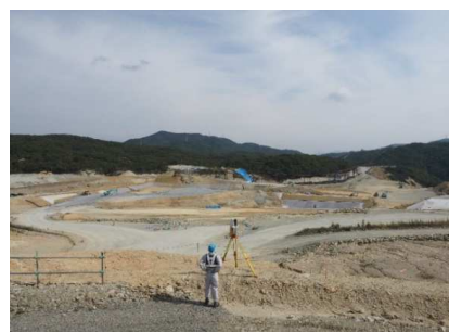
レザースキャナーによる測量状況
